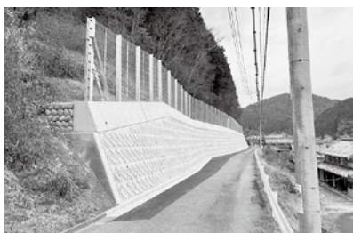
町道万場杉洞線 災害防除工事 6,509万円
